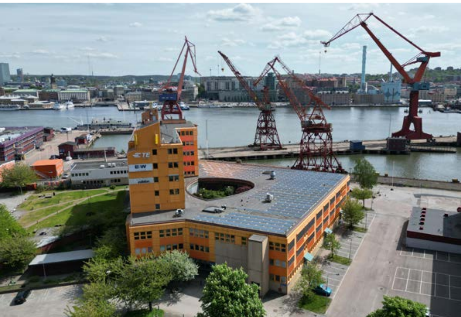
Fastigheten Galjonen – en av alla gamla varvsfastigheter på Lindholmen som ingår i vårt bestånd.
